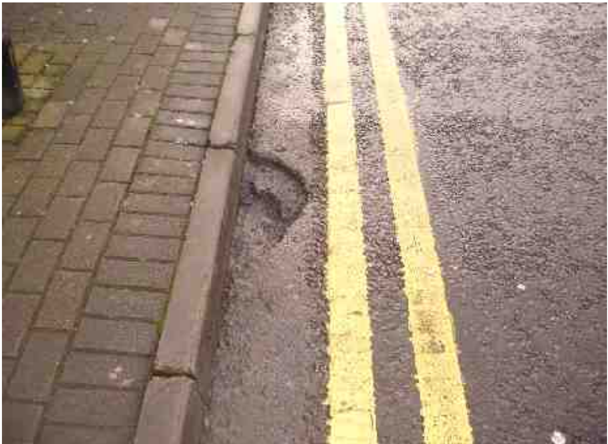
Edge breakup/cracking at road edge
